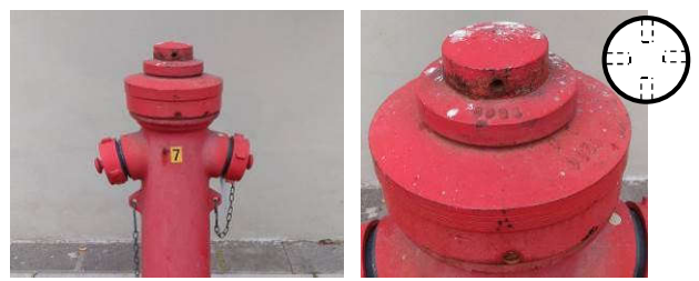
Chiave sagomata o chiave a settore con nasello \varnothing max 8 – grano di bloccaggio ch 4
