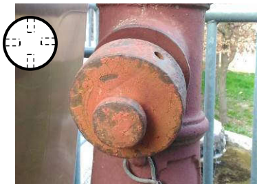
Chiave sagomata o chiave a settore con nasello \varnothing max 8
